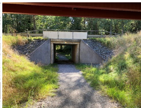
Figur 2. Bredvid gångtunneln går en GC-väg över en röd bro, längst uppe i bilden.
